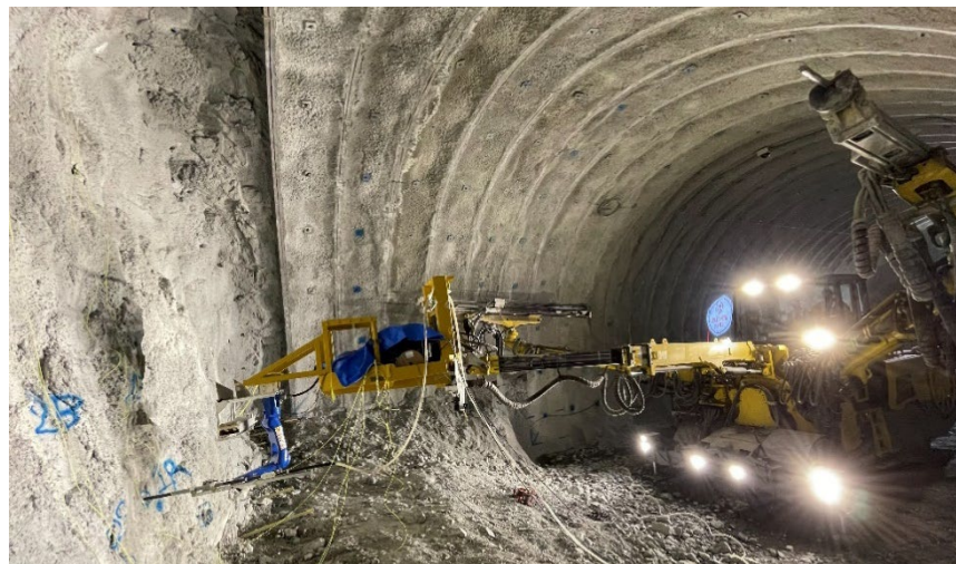
自動火薬装填システムの現場適用
