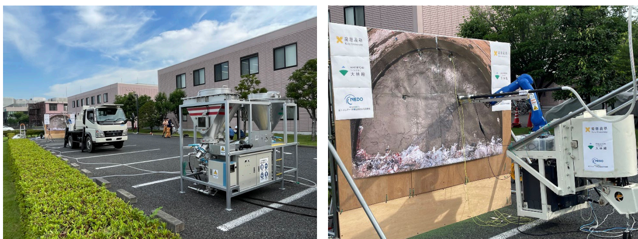
図4 火薬装填作業の自律化試験
