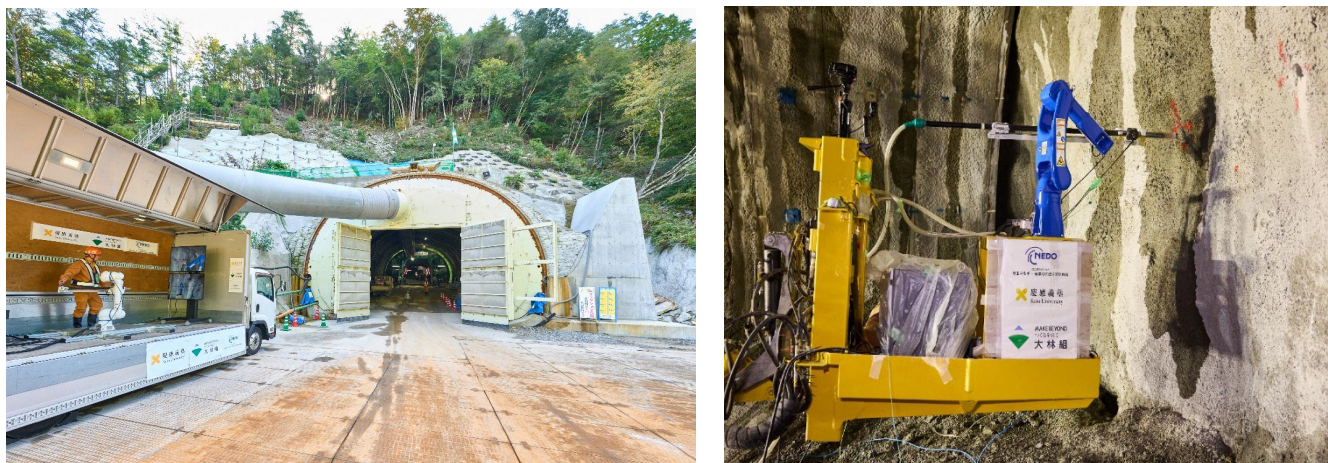
図3 トンネル外からの火薬装填状況
