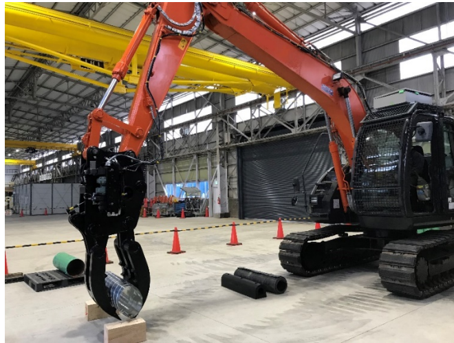
油圧駆動の建設重機による作業風景
