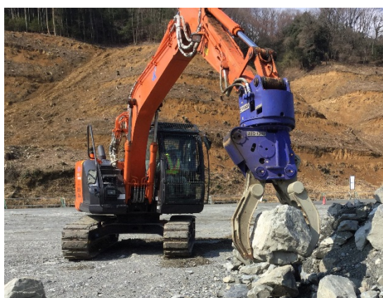
写真2 油圧駆動の建設重機による作業風景
