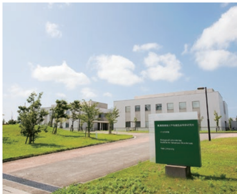
バイオラボ棟外観
