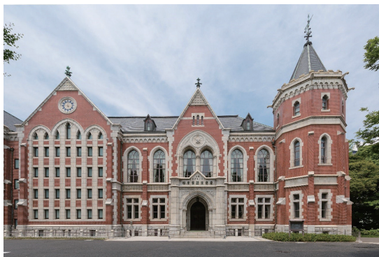
耐震工事後の図書館旧館
