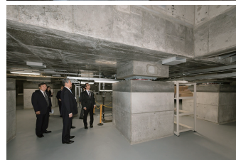
図書館旧館地下に設置された免震装置
