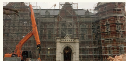
全体に足場が設置された図書館旧館
