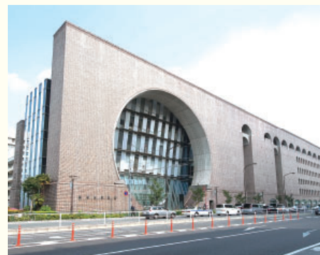
信濃町煉瓦館
